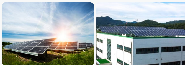
태양광 설비 신규 도입 글로벌 김치(99kw), 음성 물류(80kw), 다논(49kw)
